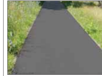
Nieuwe toplaag fietspad
